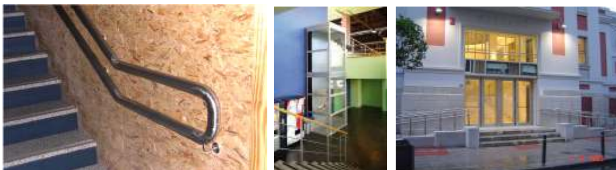
Figuras 10, 11 y 12. Detalle prolongación pasamanos en escalera; elevador vertical en instalación deportiva; rampas laterales de acceso, simétricas y encuadrando los peldaños (Mercado de Ciudad Real)
