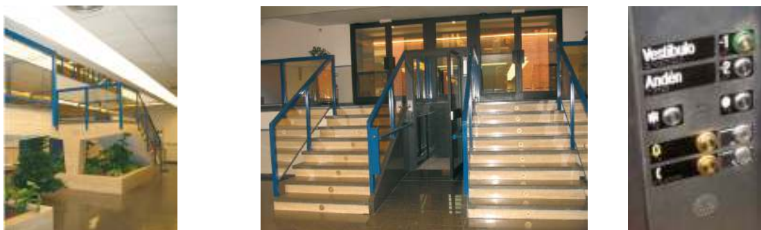
Figuras 7, 8 y 9. Protección de zanca de escalera; elevador vertical entre escaleras; detalle botonera ascensor (estación La Fortuna, Metro de Madrid)
