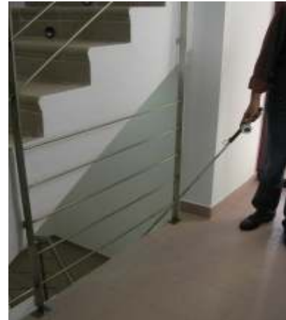
Figuras 16 y 17. Construyendo una rampa (Curso de formación de Encargados de Obra y Oficiales de Primera. Centro de la Fundación Laboral de la Construcción. Granada); barrera de protección escalable y no detectable por bastón blanco largo
